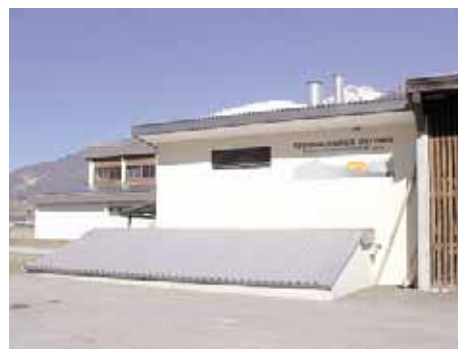
Heizung der LLA Lienz incl. Solarflächen (im Hintergrund)
