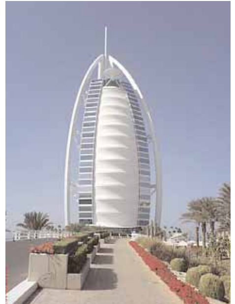
Aussenansicht Hotel Burj Al Arab
