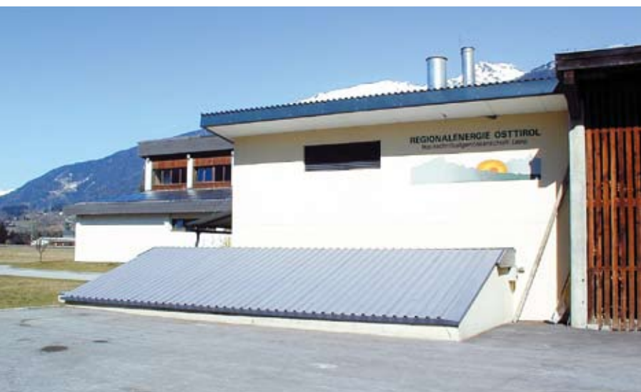
Die Hackgutheizung der Landw. Lehranstalt Lienz versorgt das Schuldorf sowie einige weitere Gebäude seit 15 Jahren mit erneuerbarer Wärmeenergie
