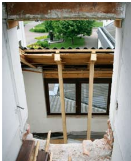
Die Phase des Abtragens ist nun abgeschlossen - der Mitteltrakt erhält neue Gebäudestrukturen mit neuem Flachdach
