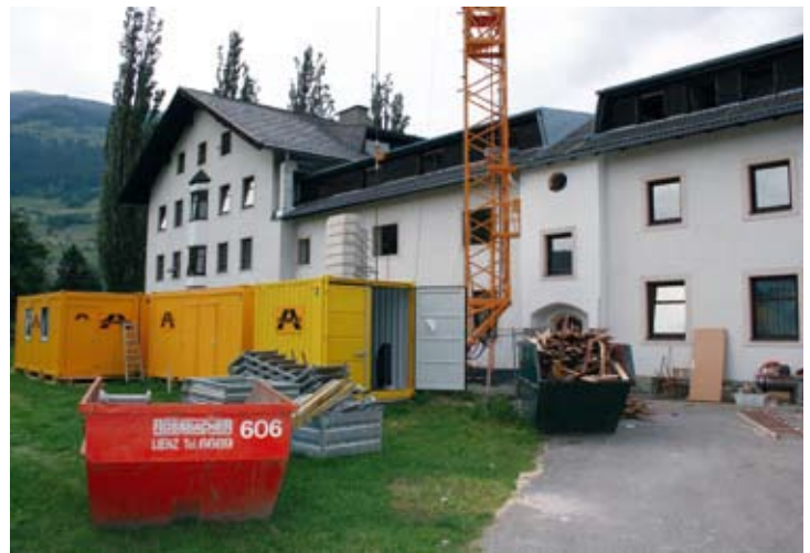
Die Baustelleneinrichtung nördlich des Haupthauses. Im Bauabschnitt 1 wird der Mitteltrakt und die Heizung erneuert
